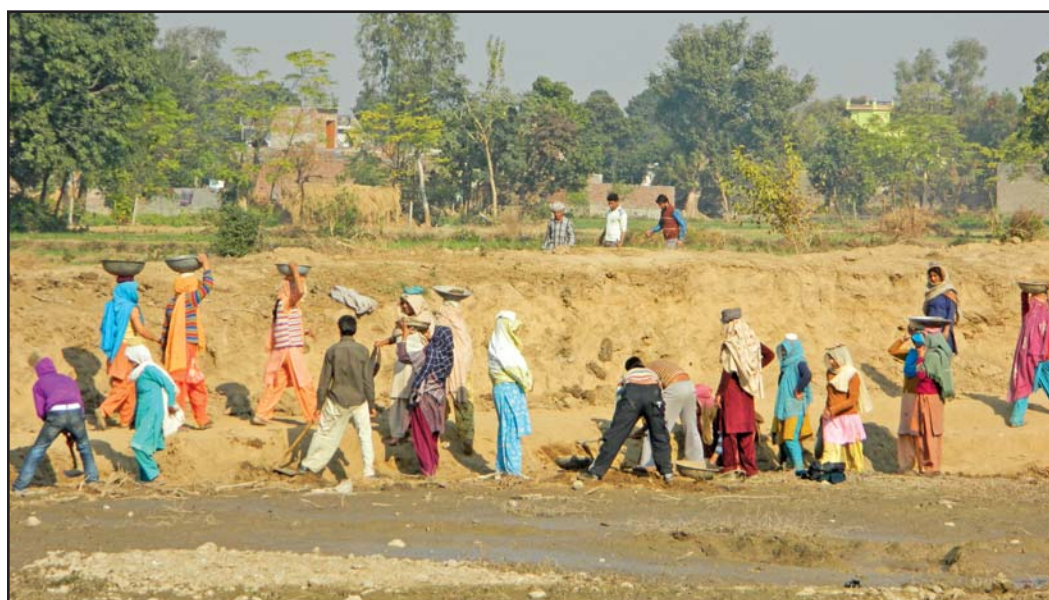
A MGNREGA site
